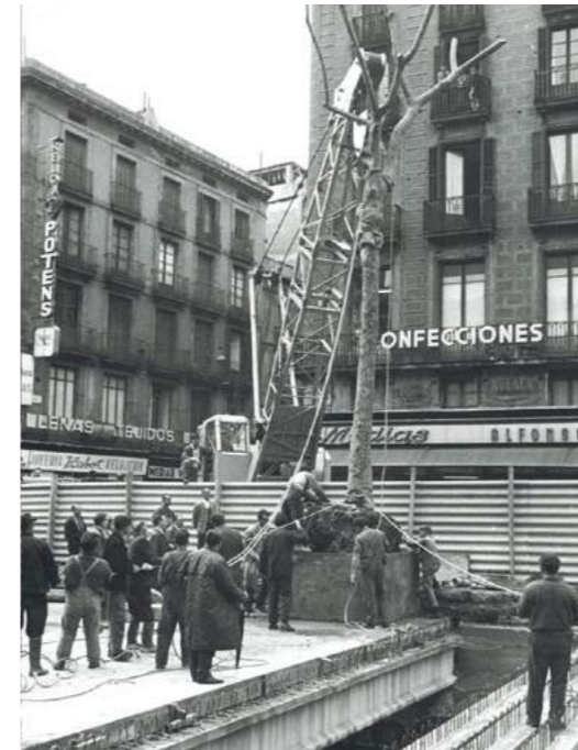
Obres del metro del Liceu. 1968
